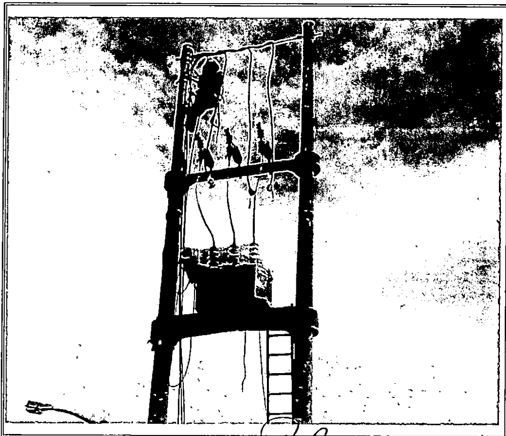
Foto N°08 En la vista se aprecia los trabajos de conexión entre sus componentes en el transformador.
